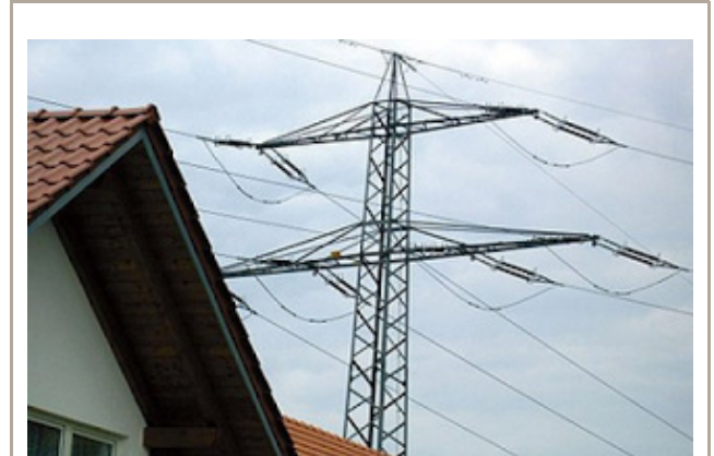
Die Gefahr für Kinder, Hochspannungsleitungen
